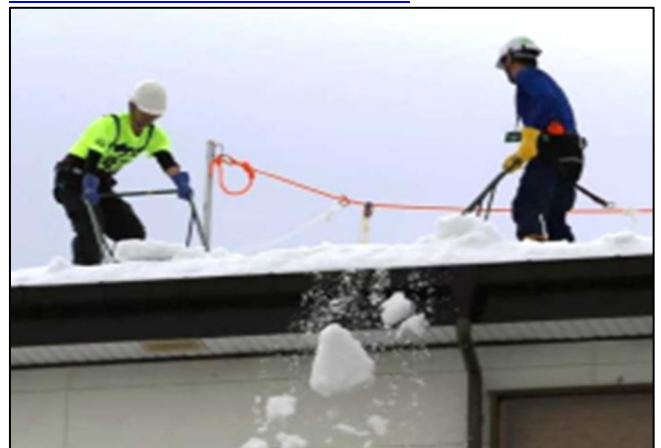
命綱、ヘルメットを装着して作業する様子（提供：新潟県）
